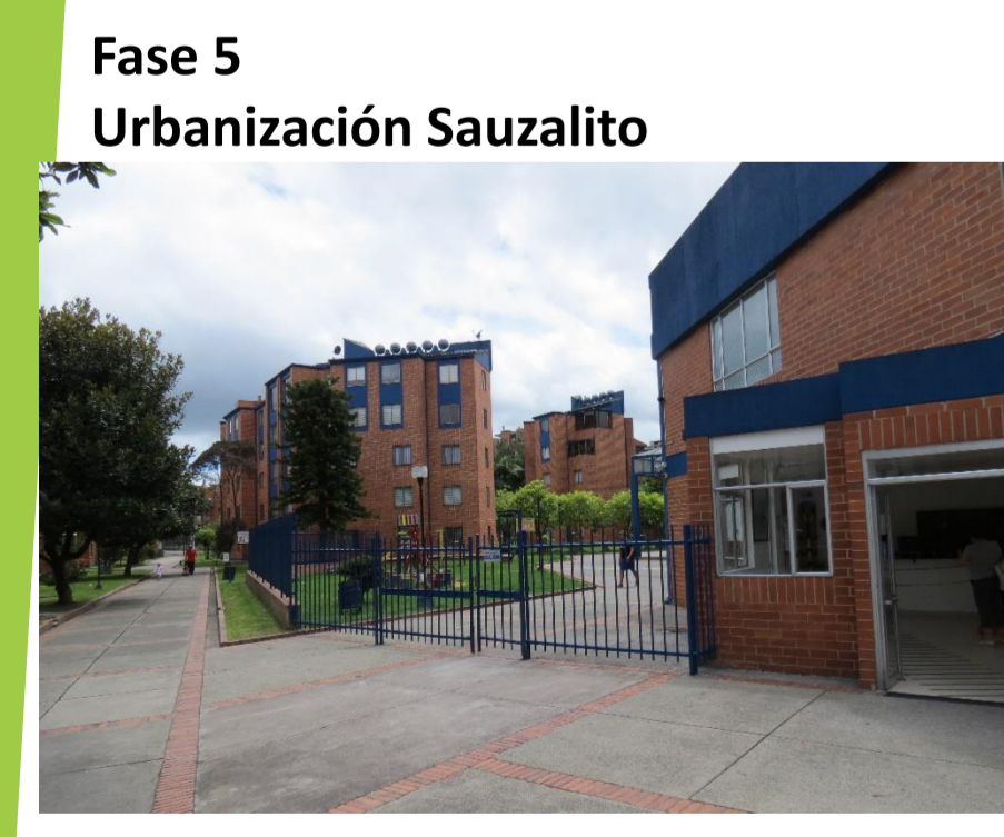
Urbanización Sauzalito, acceso. (Tomada por Olavo Escorcía)
