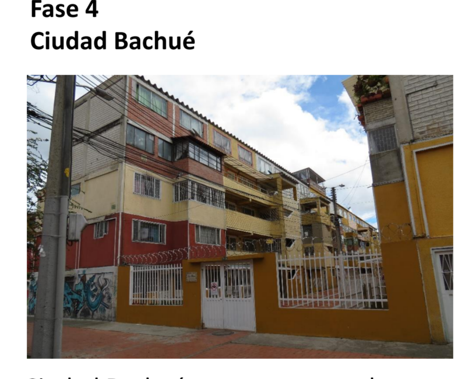
Ciudad Bachué, acceso peatonal. (Tomada por Olavo Escorcía)
